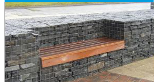
Muret en gabion
